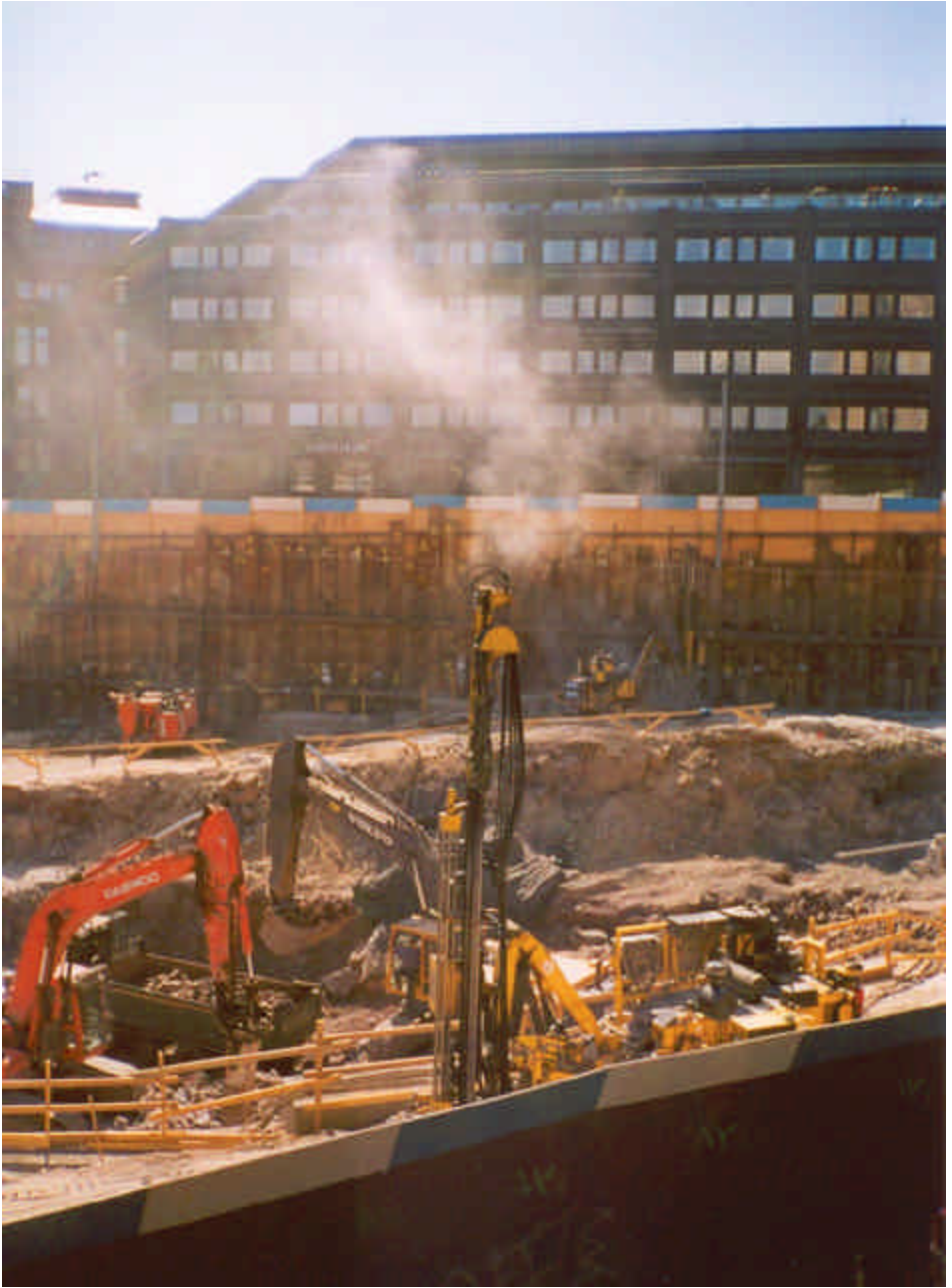
Innotalo eduskunnan lisärakennustyömaan takana elokuussa 2002. (Kuva: M. Alameri)
