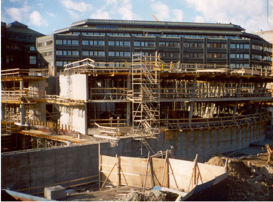
Innotalo eduskunnan lisärakennustyömaan takana toukokuussa 2003.
