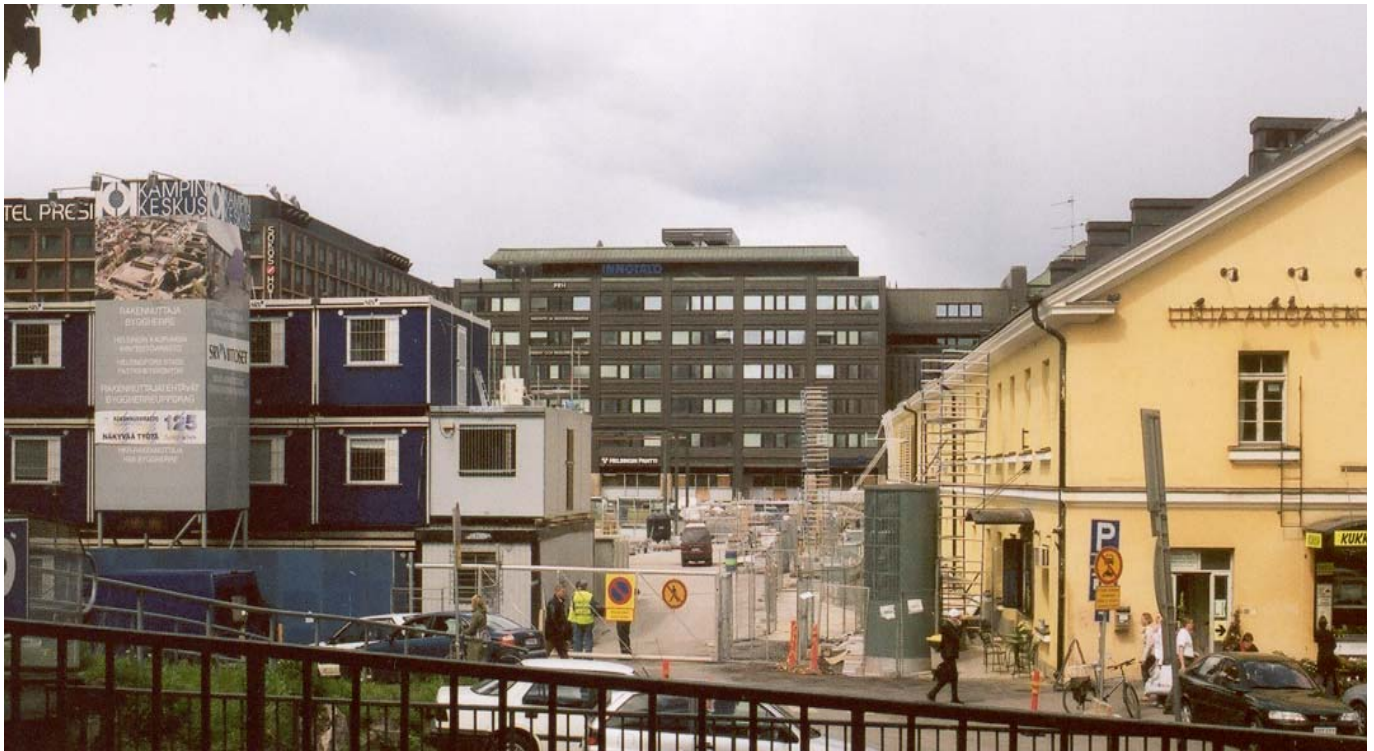
Innotalo, Kampin keskuksen rakennustyömaa ja Helsingin linja-autoasemarakennus keväällä 2005. (Kuva: Mikko Alameri)
